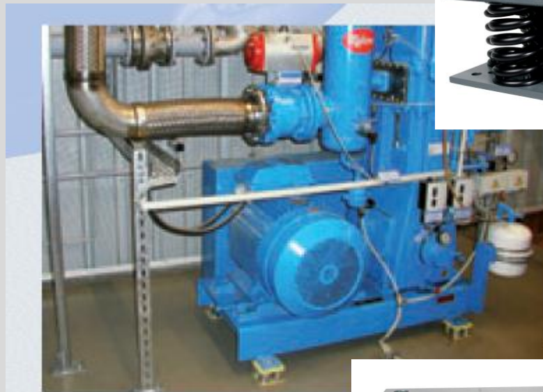
Компрессор установлен на пружинные демпферы, внутри пружин которых, находятся металлические амортизационные подушки
