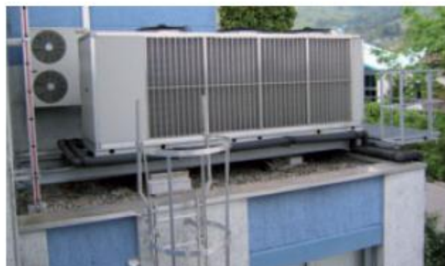
Изоляция системы кондиционирования
